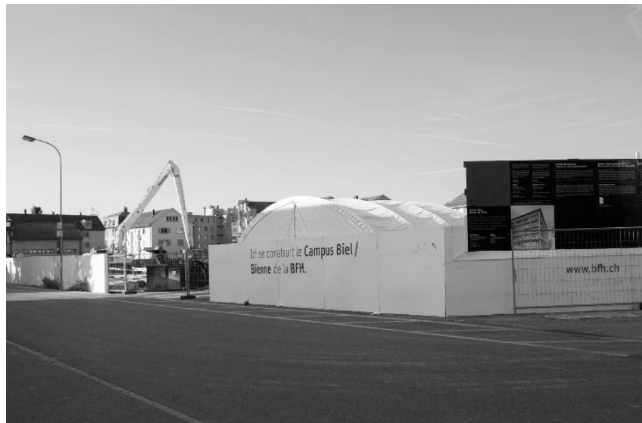
Chantier du Campus Biel/Bienne de la Haute école spécialisée
