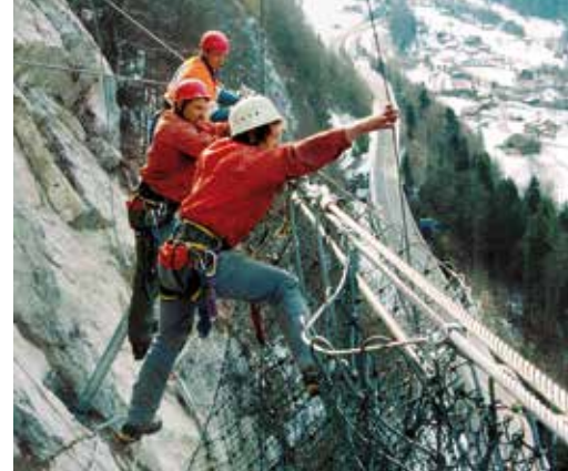
OFOR (treillis de sécurité au-dessus de l'A8 près d'Iseltwald)
