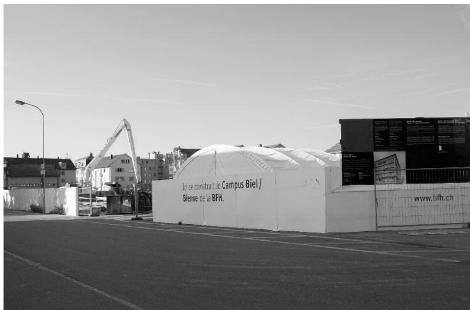
Baustelle Campus Biel/Bienne, Fachhochschule
