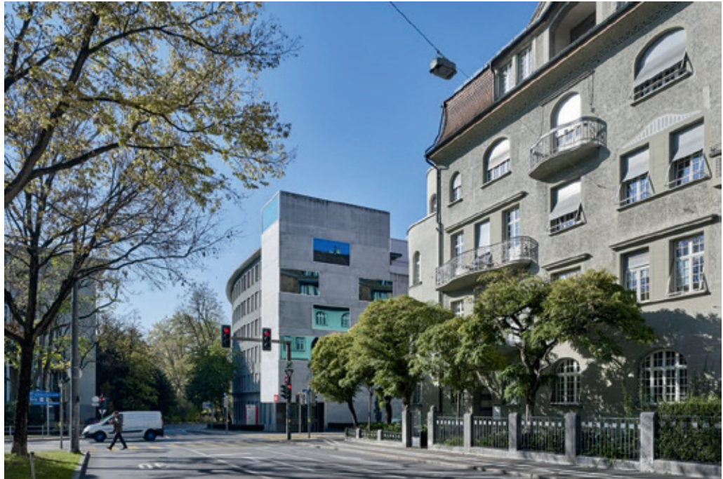
Abb. 11: Das SRF Radiostudio im Berner Monbijouquartier ist ein Beispiel für die Siedlungsentwicklung nach innen an einem zentralen Ort. Das Gebäude knüpft an Bestehendem an, nimmt Elemente des Umfelds auf und prägt den Ort trotzdem neu.
