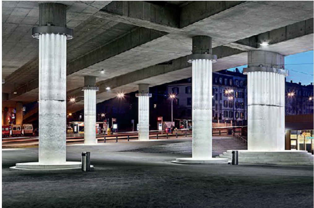
Abb. 31: Autobahnviadukt am Europaplatz, Bern. Infrastrukturbauten können eine starke Trennwirkung im Siedlungsgebiet entfalten, mit einer durchdachten Nutzung und Gestaltung aber auch einen Beitrag zur Aufenthalts- und Lebensqualität leisten.
