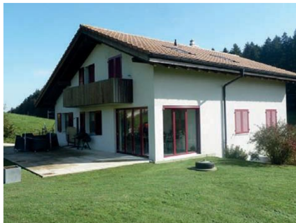
Vitrage d'un renforcement de bâtiment
