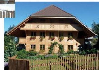
Reconstruction d'une petite ferme après sa démolition
